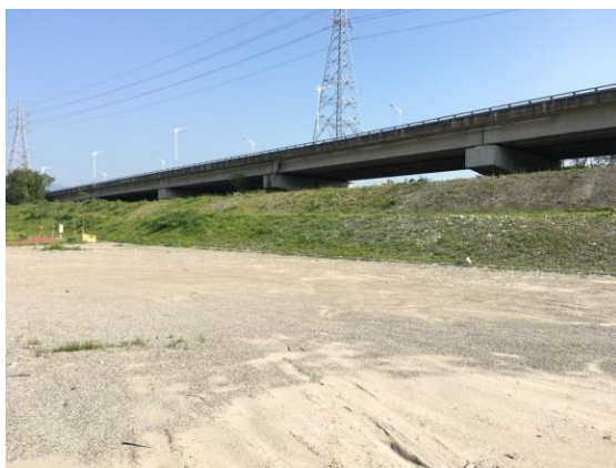
南側土坡現況
