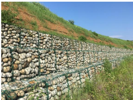
北側邊坡現況
