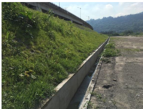
南側排水渠道現況
