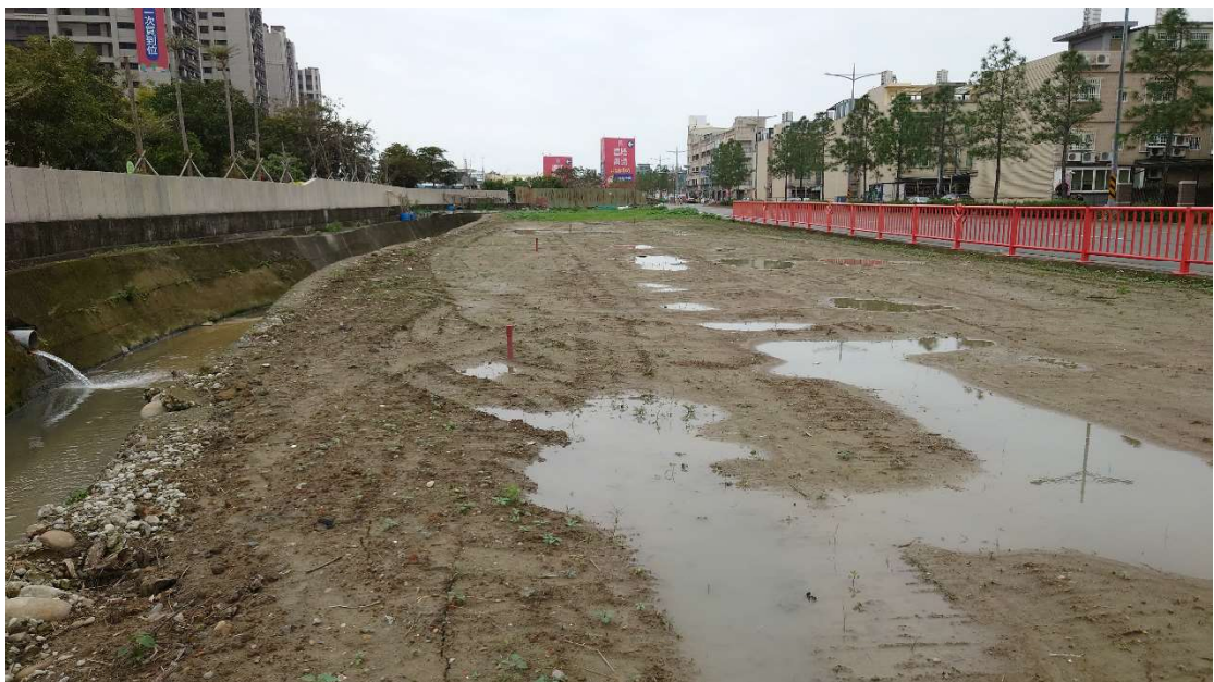
圖 14、調查範圍隆恩圳西段一景，堤岸旁空地經整地現為空地。
