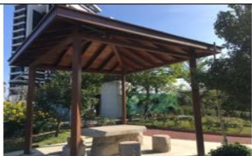
沿線既有休憩設施
